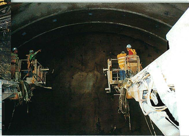
⇨ 2ブームバケットより 装薬作業中
