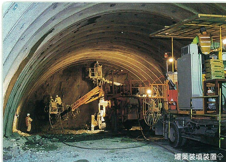
⇩ 後方より切羽をみる 装薬作業中
