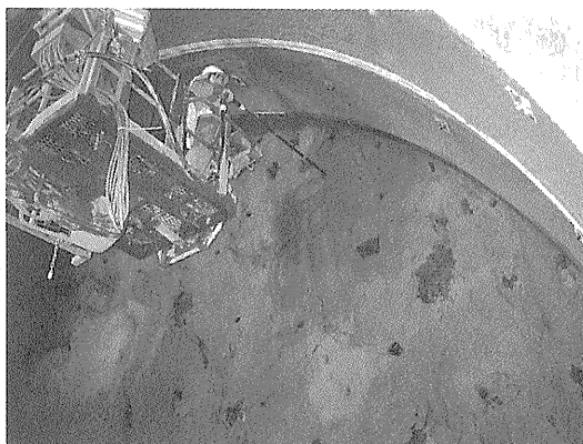
写真-2 実現した遠隔装填作業
