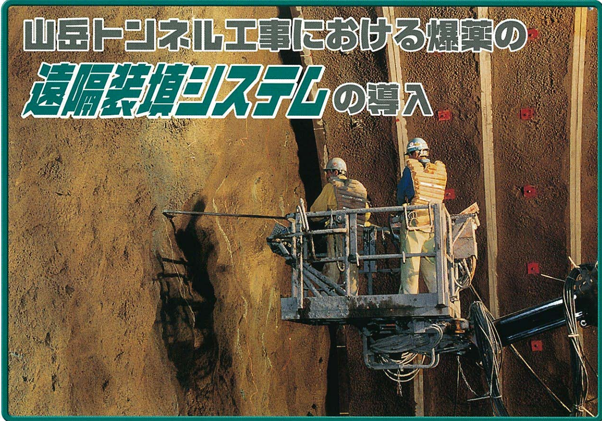
⇨ 装薬作業 切羽から離れて作業出来る
