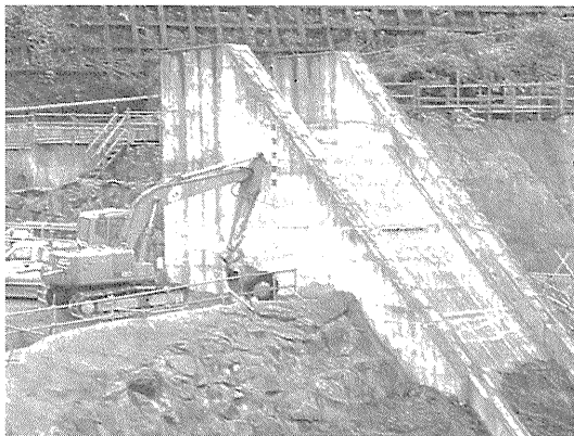
写真—9 インクライン基礎全景
