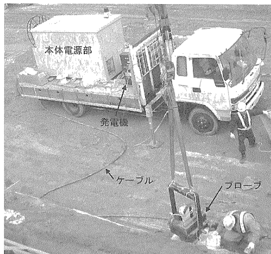
写真-3 現場作業状況
