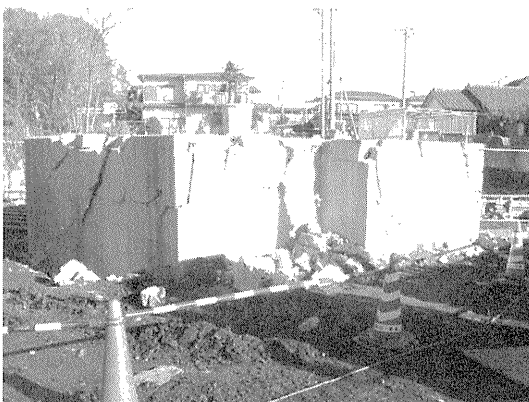
写真—11 ケーブルクレーン基礎解体工事
