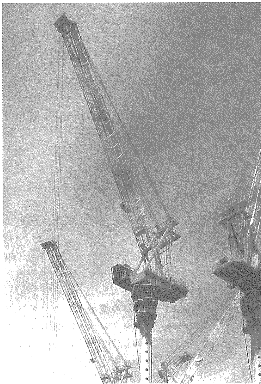
写真—2 大型タワークレーン
