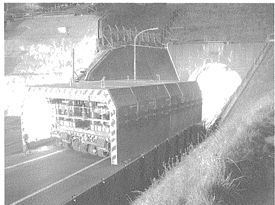
写真—6 プロテクタ搬入状況
