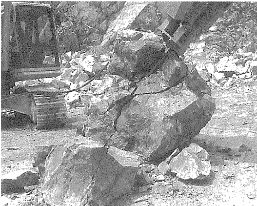
写真—7 硬岩破碎状況
