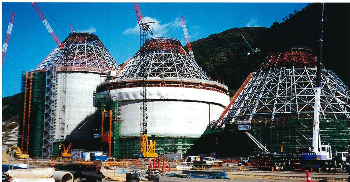
⇨サイロ筒体スリップアップ工事中
