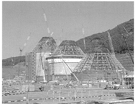
写真-1 石炭サイロ工事全景
