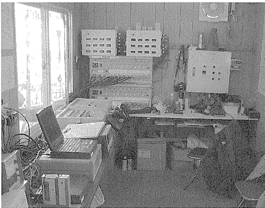
写真—5 司令室内部
