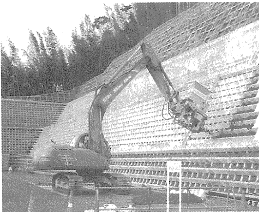
写真-5 バックホウを利用した施工状況
