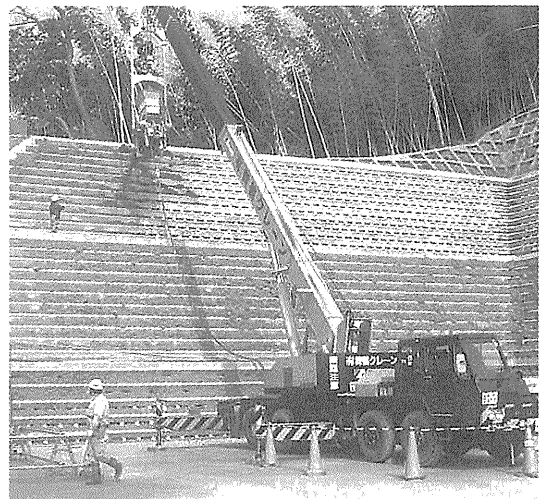
写真-7 トラッククレーンを利用した施工状況
