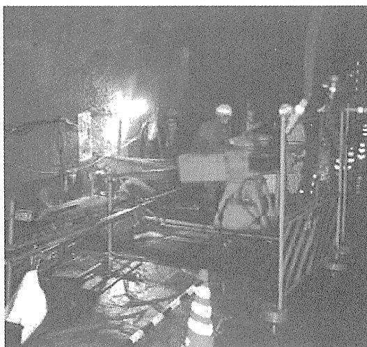
写真一3 ダイナプレス工法実施状況
