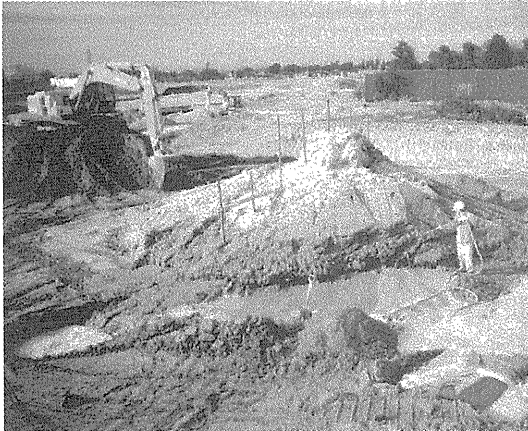
写真—2 注入改良体の掘出し状況
