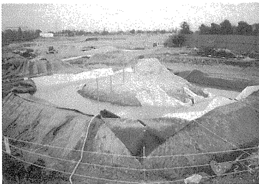
写真—3 人工トレーサ溶液の水張り試験状況
