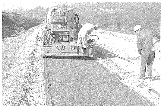
写真-7 舗設状況
