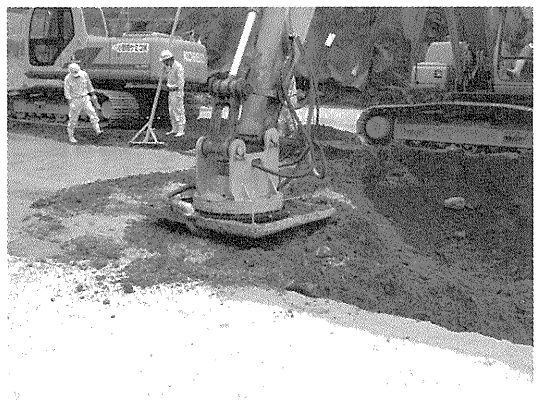
写真-2 攪拌混合状況
