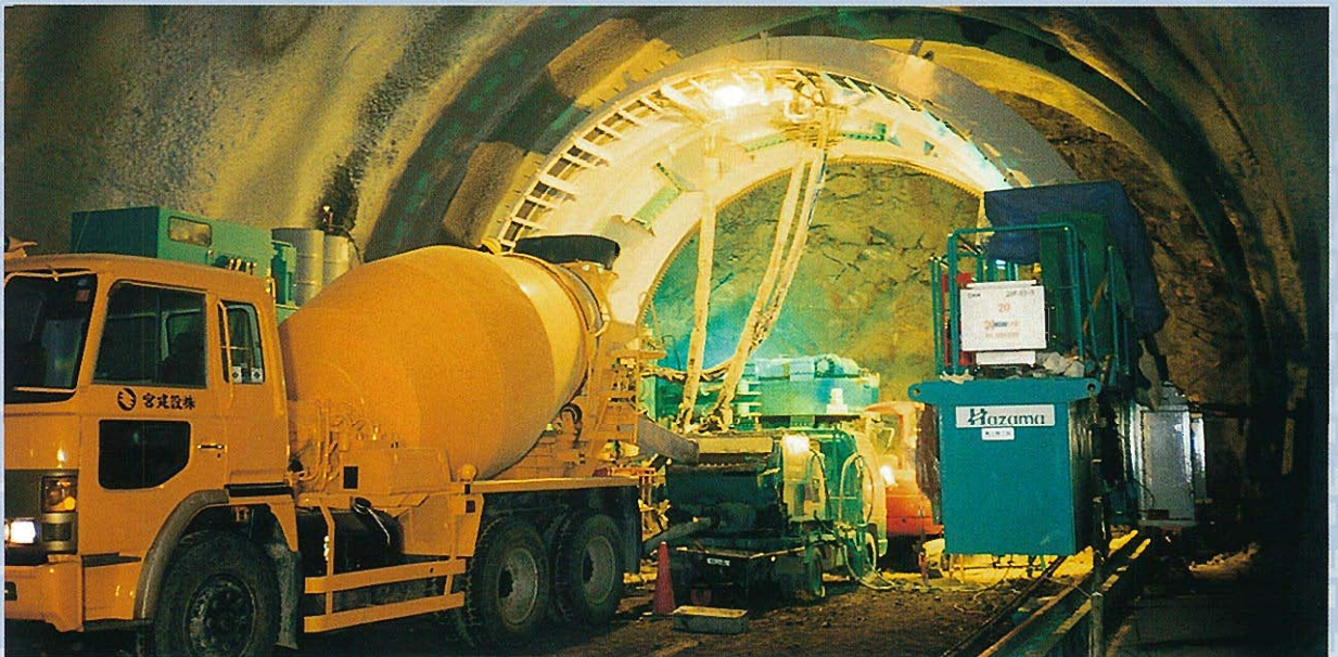
↑コンクリート充填状況
