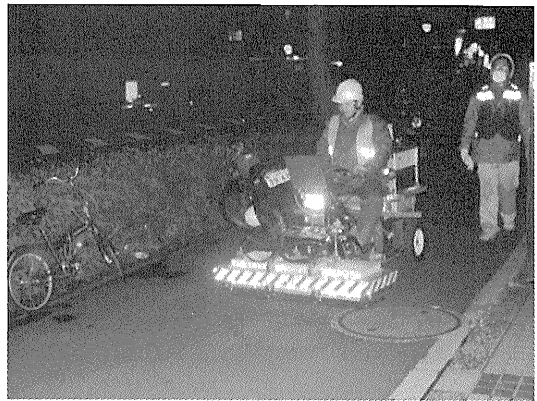
写真-3 現場試験状況
