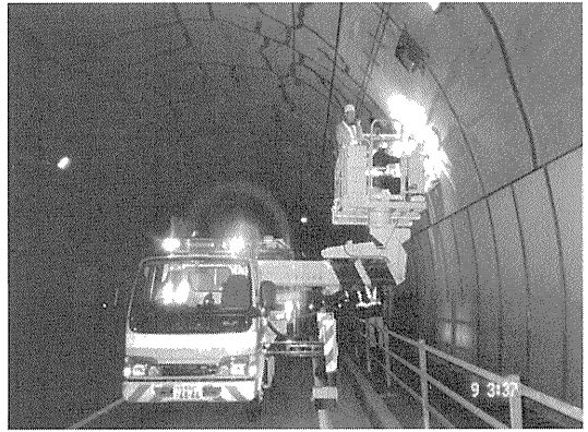
写真-6 Tトンネル (10測線)
