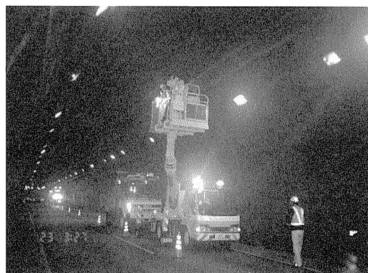
写真-4 Kトンネル (5測線)
