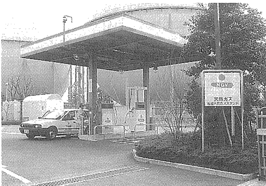
写真-1 燃料(天然ガス)供給施設
