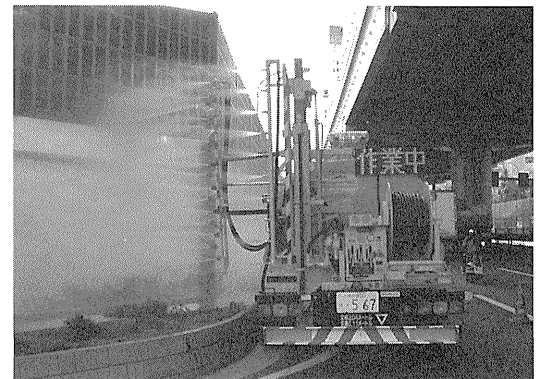
写真-9 透光性遮音壁清掃車作業状況
