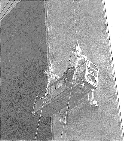
写真—1 オーバハング部を昇降する磁石車輪ゴンドラ
