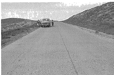
写真-10 旧ロシア政府が作ったコンクリート舗装道路
