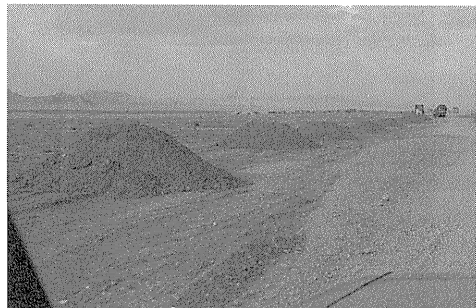
写真一 9 イラン政府支援の道路整備
