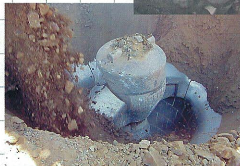
投入口:投入状況2
