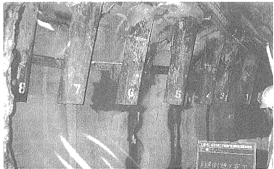
写真—7 側壁導坑への到達状況
