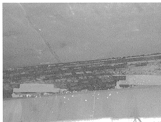
写真—6 はつり処理出来形
