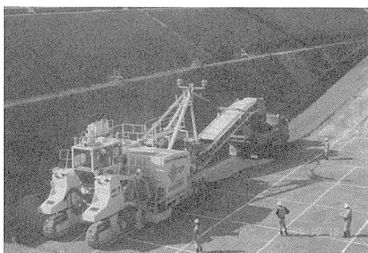
写真一2 岩盤切削機掘削試験状況
