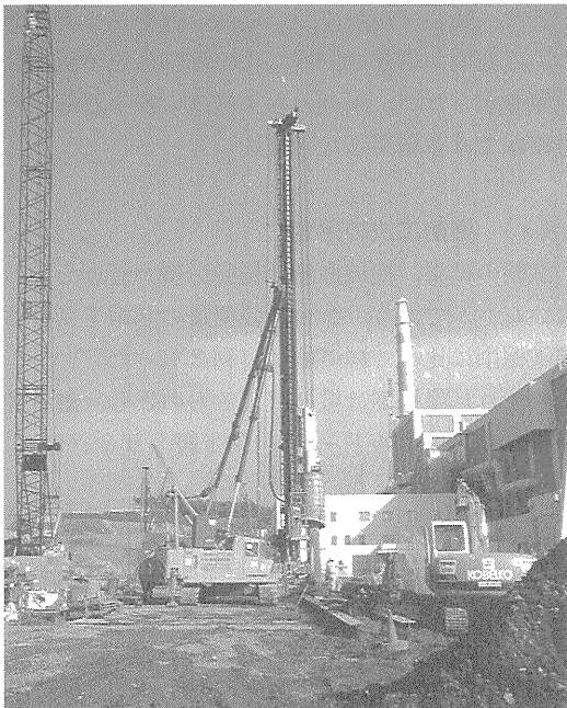
写真—4 ダウンザホールハンマ削孔状況
