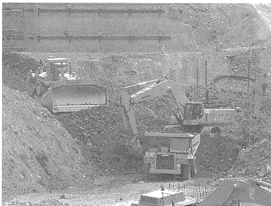
写真-6 基礎掘削状況
