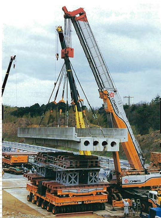
⇩中央径間(190t)を撤去した1号機
