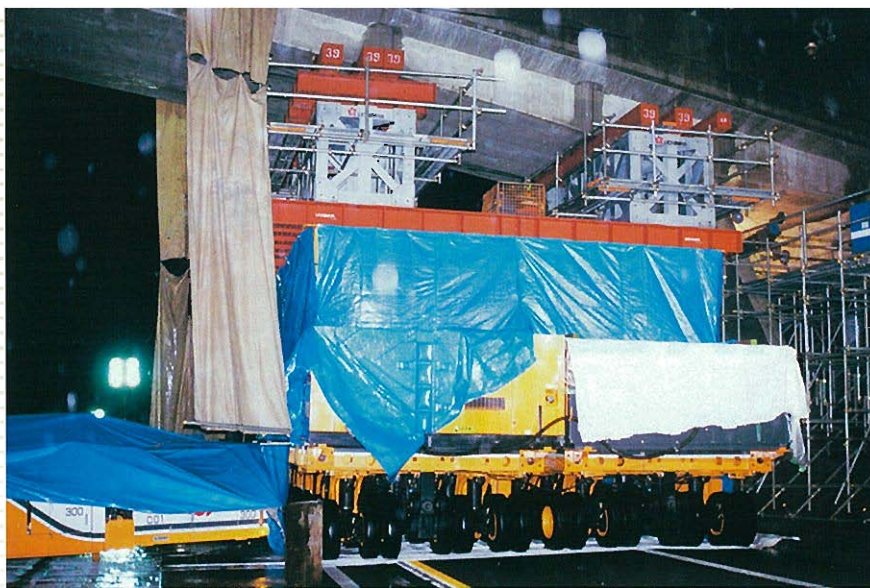
登り線側中央径間を⇒ 仮受中の2号機
