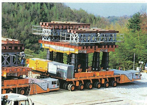
⇨2号機のデッキリフト延伸試運転
