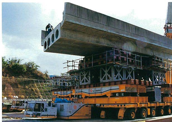
⇩1号機上の下り線側中央径間
