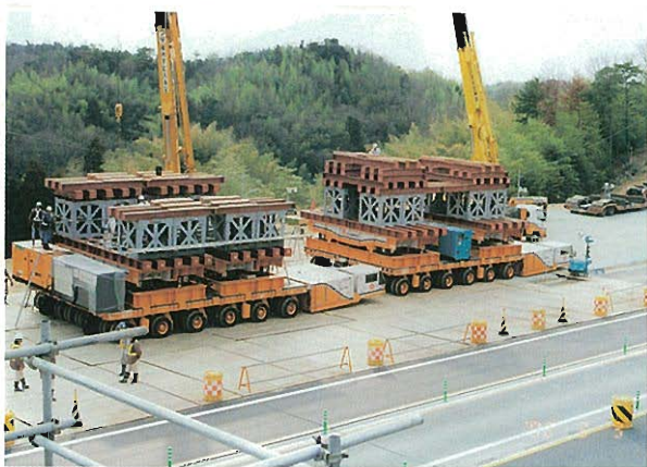
⇨組立中の2号機(手前)と1号機
