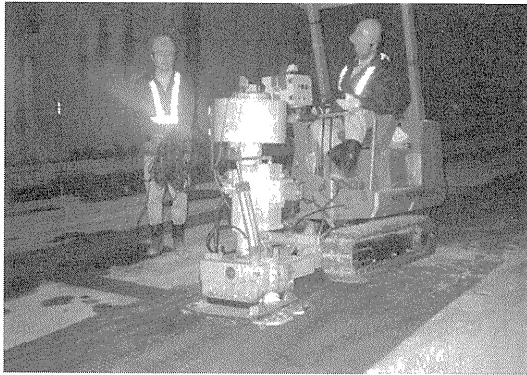
写真—1 油圧インパクトによる起振状況
