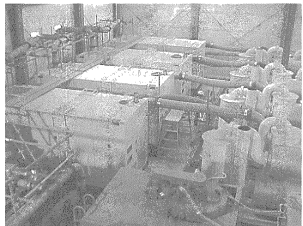
写真-2 吸引排土装置
