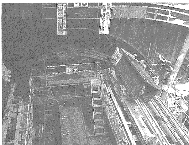
写真-3 発進架台
