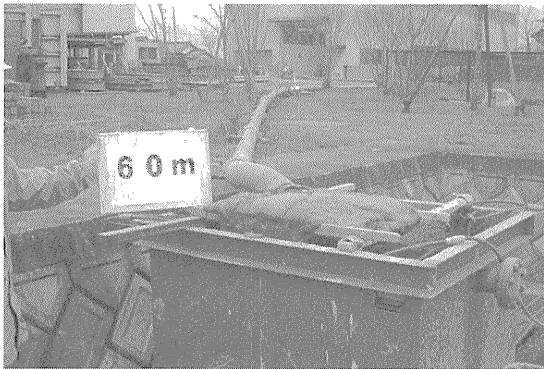
写真-5 排土状況 (圧送距離 60 m 地点)
