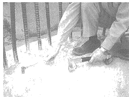
写真-2 場所打ちコンクリート杭の杭頭強度確認
