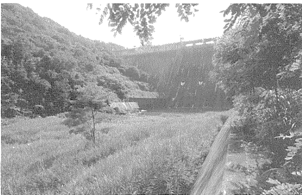
写真一2 着工前
