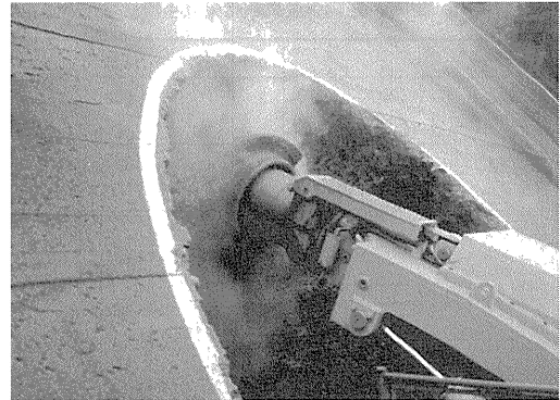
写真-5 堤体削孔開始
