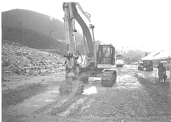
写真-2 ツインヘッドによる仕上げ掘削
