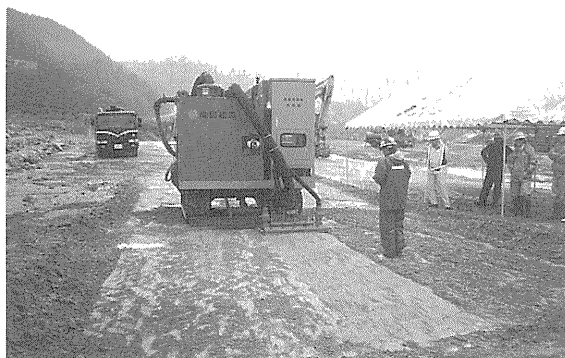
写真-3 無線操縦による清掃状況
