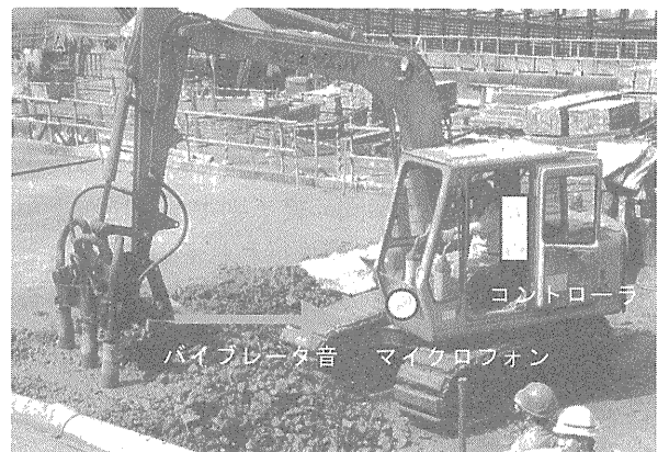
写真-3 締固め時の音の測定方法
