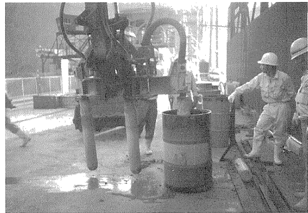
写真-1 現場締固め試験状況
