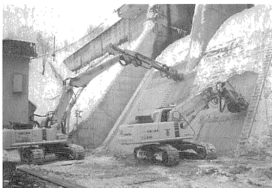
写真-6 堤体切削状況
