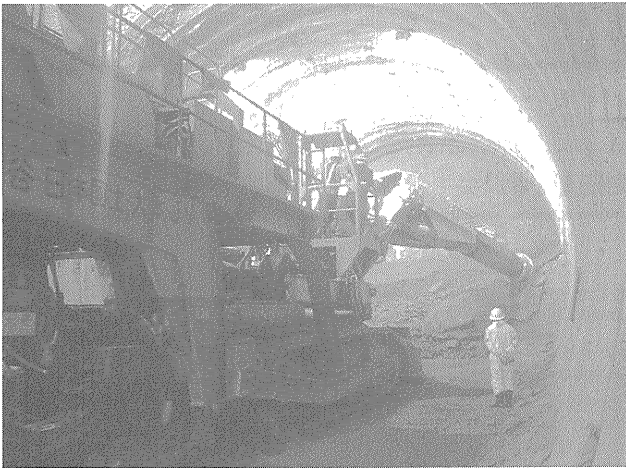
写真-1 自由断面掘削機
