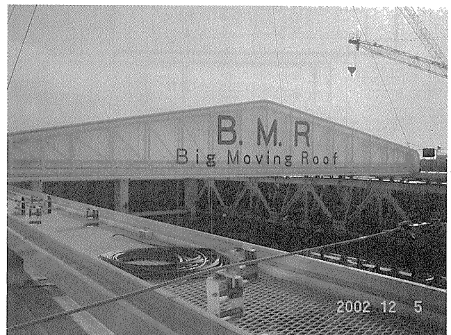
図-5 スライド式開閉シート屋根
