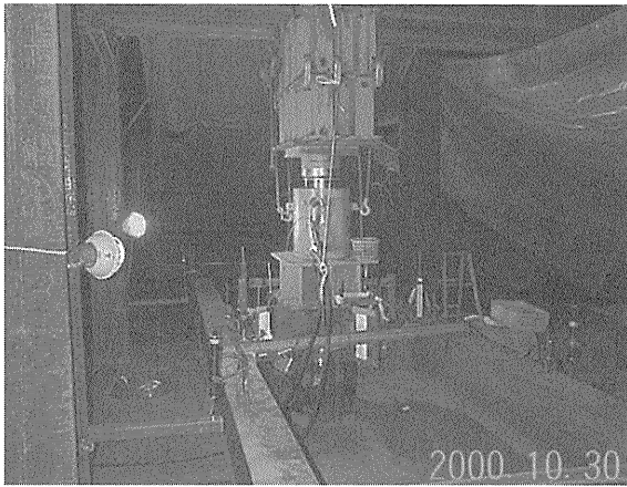
写真-7 杭載荷試験状況
