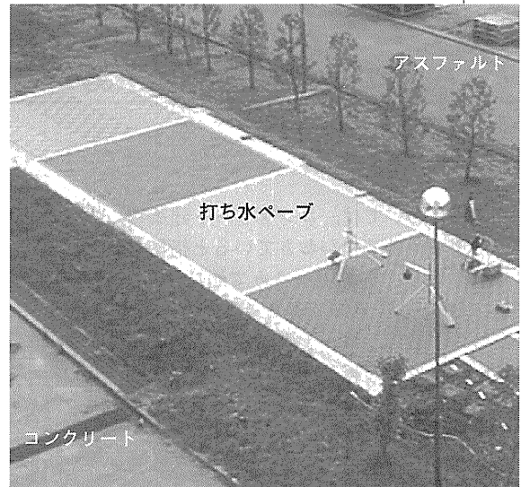
写真-1 打ち水ペープ施工例
