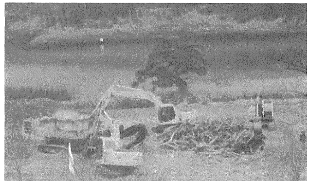
写真-3 リフォレ BR 200 T による破碎状況
