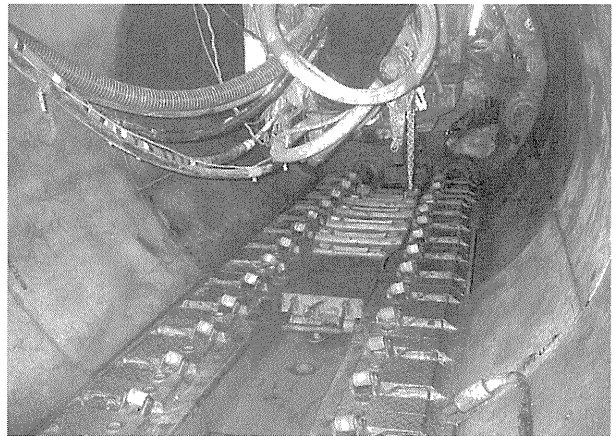
写真—4 セグメント供給システム
