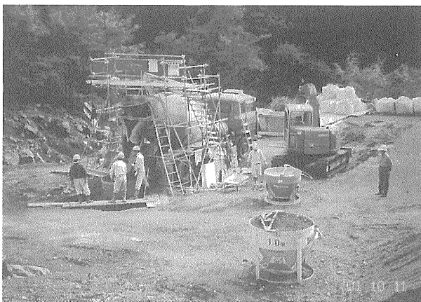
写真-9 アジテータ車による砂防 CSG 材製造状況
