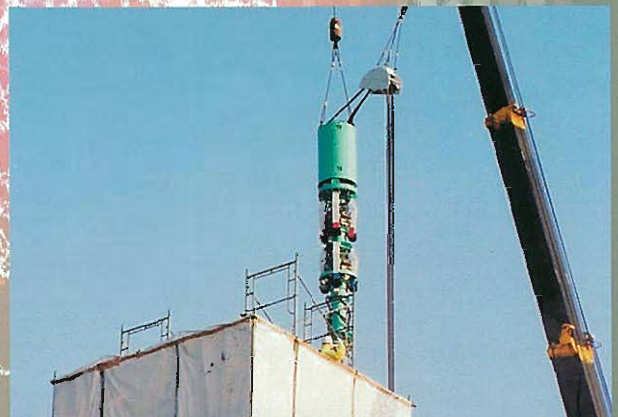
⇩頂部ロボット投入状況(2号機)
