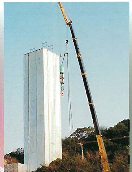
⇩施工全景(2号機)
