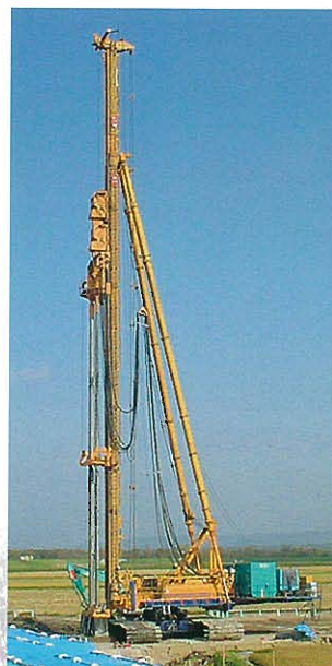
↑大量施工用機械 (翼径1.6m×2軸、 貫入深度28m)
