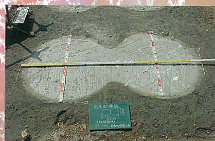
↑改良体出来形(翼径1.6m×2軸)
