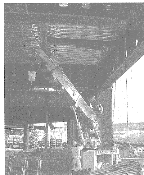
写真-1 設置状況 (その1)
