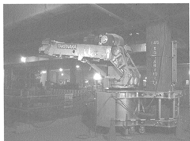
写真-2 設置状況 (その2)
