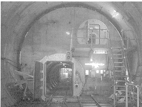
写真一8 坑内写真
