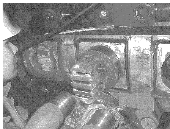
写真-3 ビット交換状況 (No.1 スポークスライドフレーム引抜き、ビット交換時)
