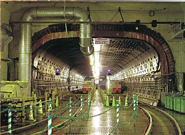
↑ 坑内作業状況（坑口より見る）
