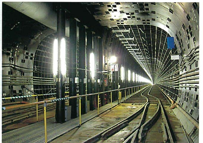
↑ 坑内覆工状況（渡り線部から一般路線部への境界）
