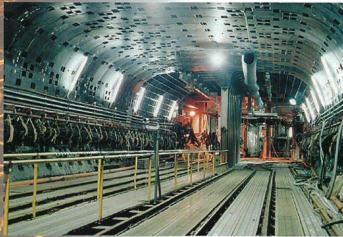
↑ ダクタイルセグメントによる覆工状況（一般路線部）
