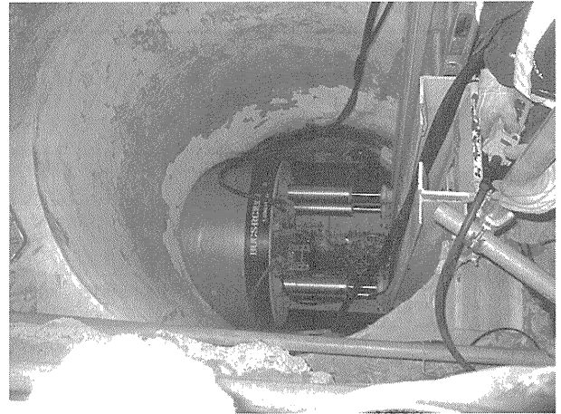
写真-2 工事状況
