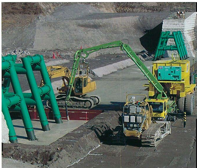
⇩ 高流動コンクリート打設状況
