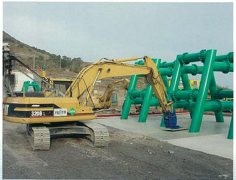
⇨コンクリート天端押さえ状況
