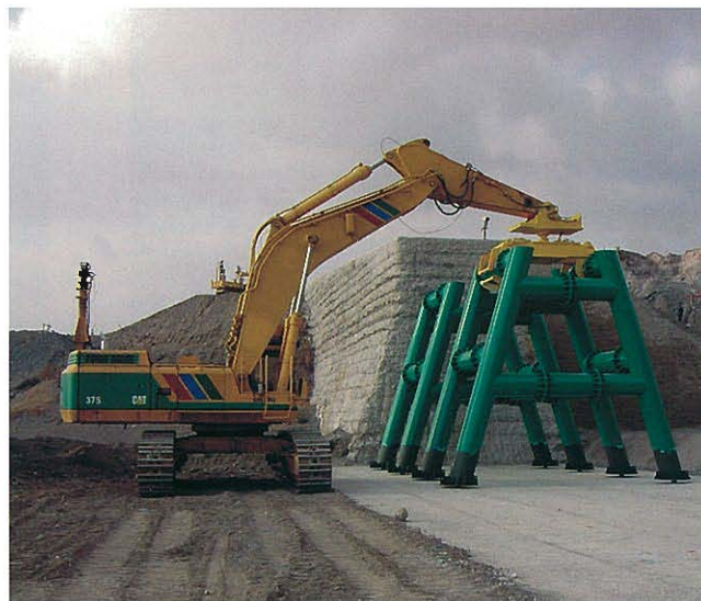
⇩ 鋼製スリット据付状況
