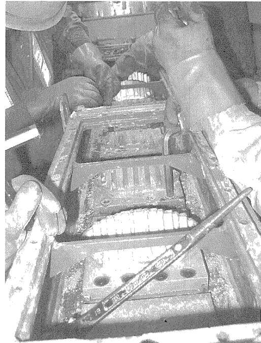
写真—11 特殊先行ビット交換状況
