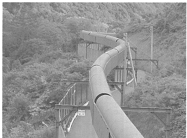
写真-2 U型トラフカーブコンベヤ
