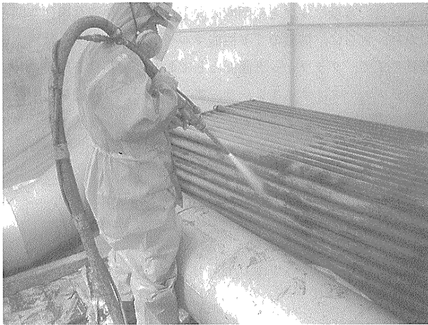
写真-1 焼却施設の除染作業
