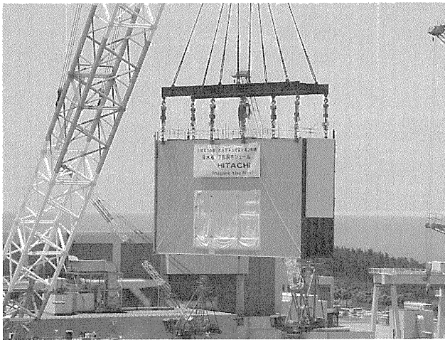
写真-5 復水器下部胴吊込み
