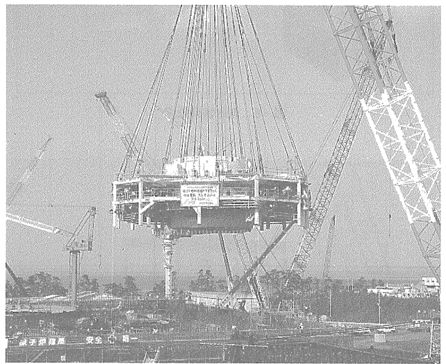
写真-4 ドライウェルモジュール吊込み
