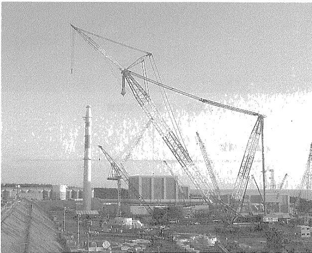
写真-1 クレーン全景写真
