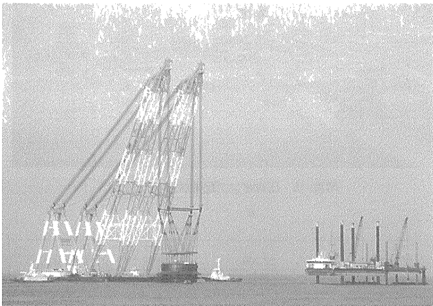
写真—3 曳航・据付け状況
