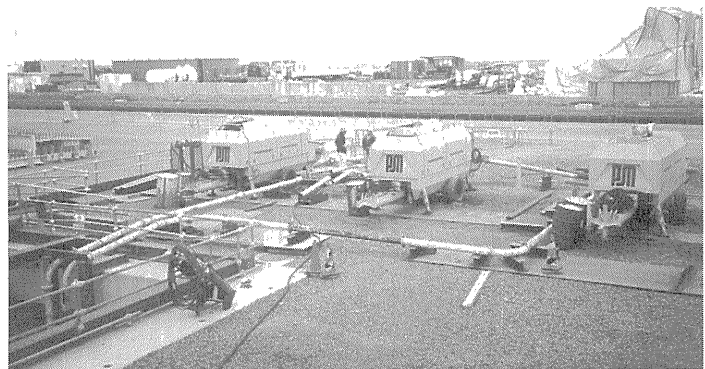
写真—5 圧送ポンプ配置状況
