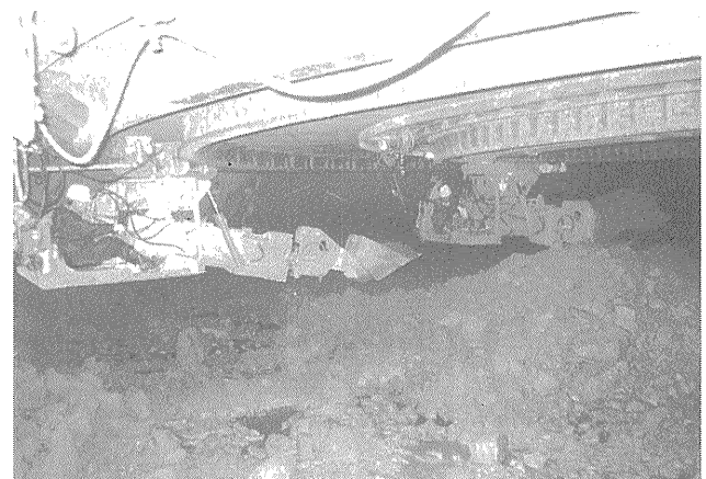
写真—4 沈下掘削状況
