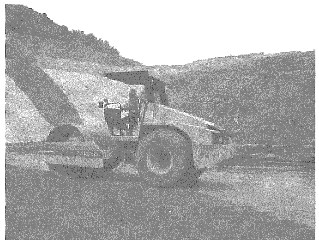
写真-4 改良土転圧状況
