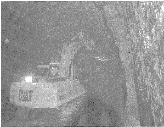
写真-5 中詰土掘削状況
