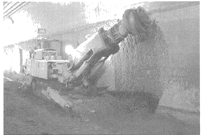
写真-6 トンネル側壁コンクリート切削状況
