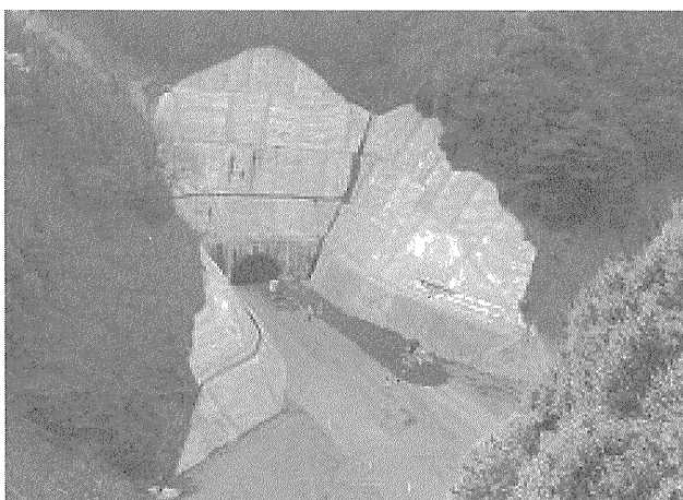
写真-2 改良土盛立て状況全景
