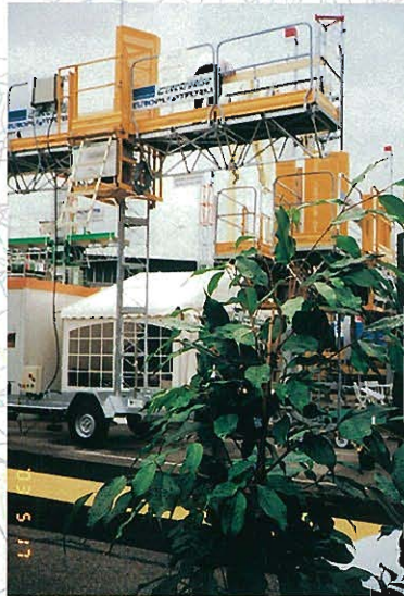
⇧Photo21/ マスト昇降式作業台
