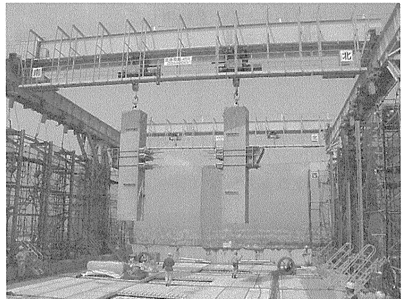
図-2 プレキャスト柱揚重作業
