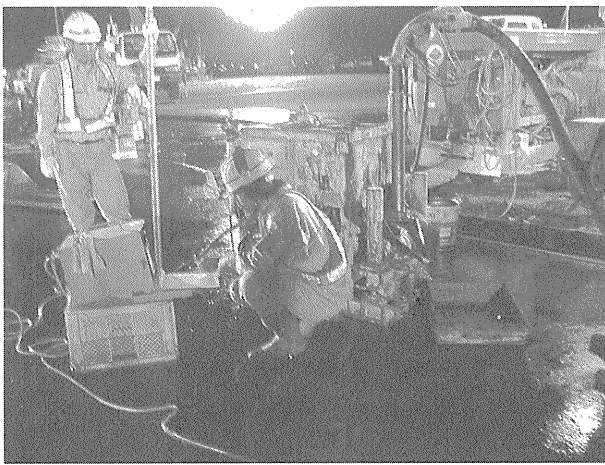
写真一2 注入管リフト装置
